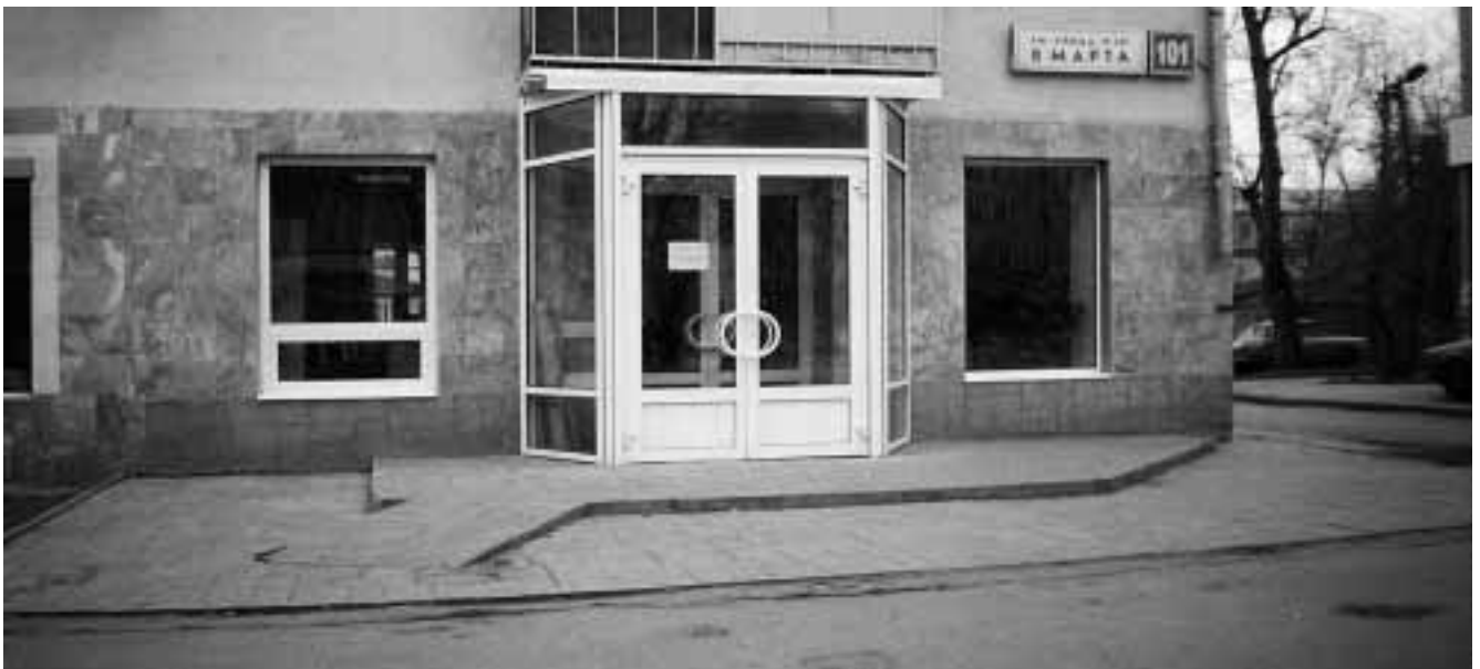
3. Пандус на плиту перед входом
